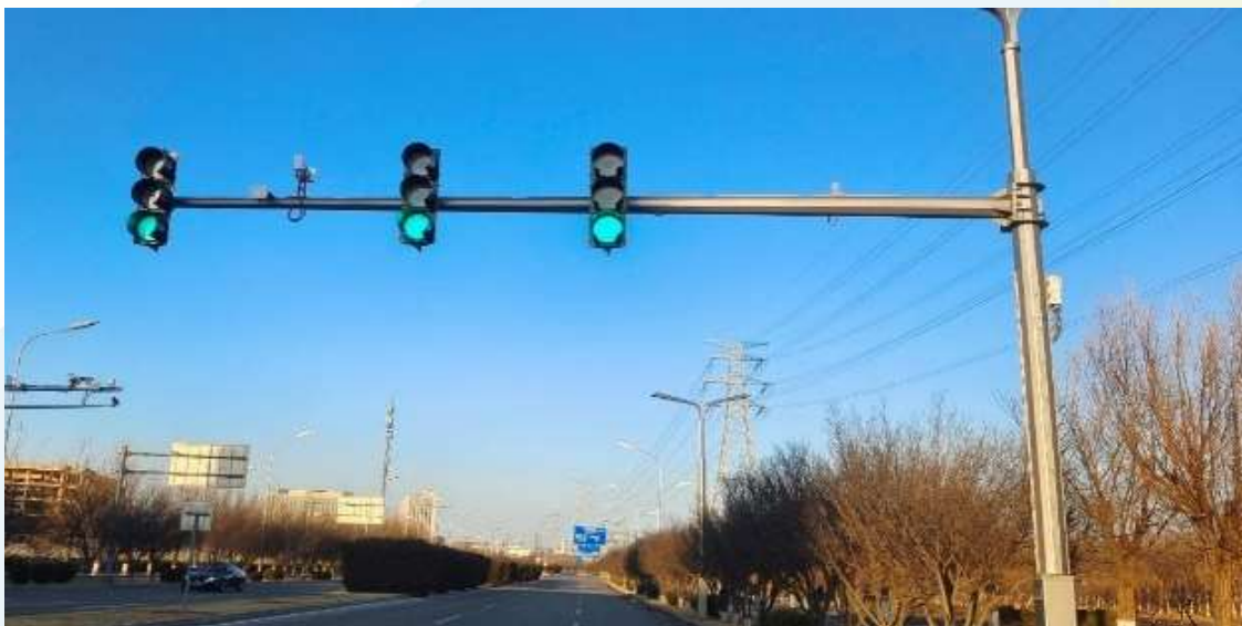
图1-7 专网路侧基站及天线实景图
