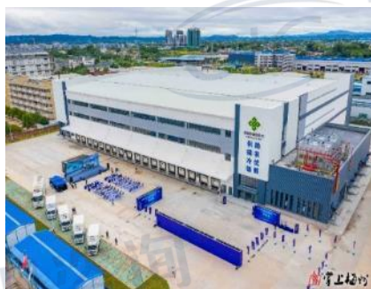
广东供销天兴冷链物流中心— 梅州首个冷链物流项目，库容3 万吨、总投资1.5亿元
