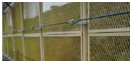
图5 机场应用实景
